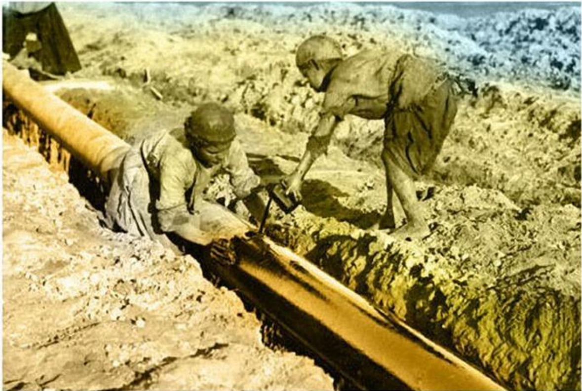
عایق کاری خط لوله نفت مسجدسلیمان به آبادان با ماده قیری بوسیله کودکان بختیاری جهت جلوگیری از خوردگی در زیر زمین
